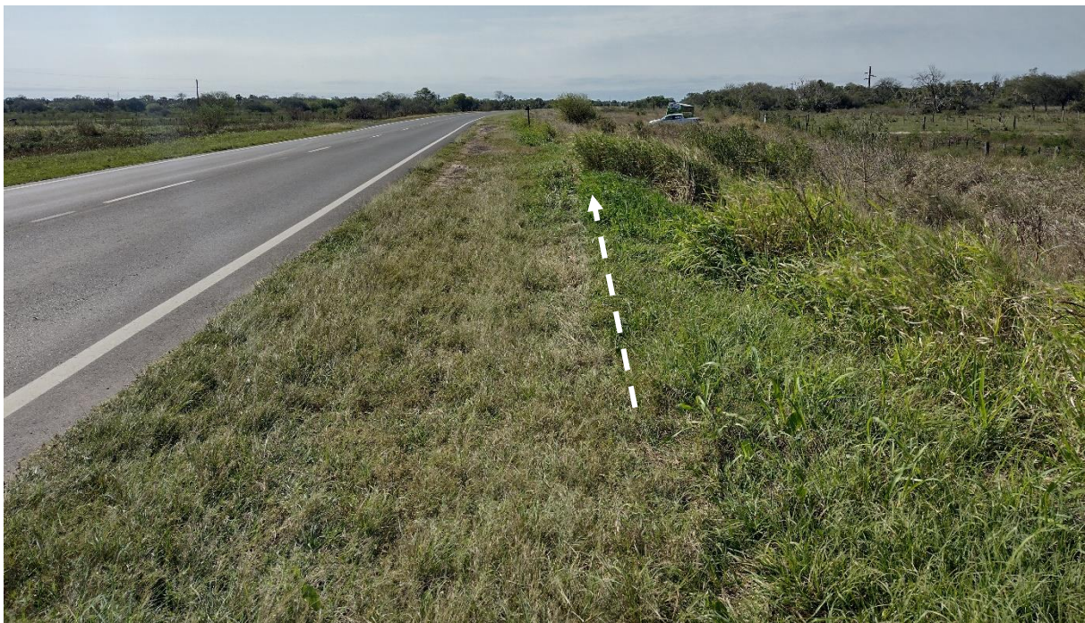
Figura 9. En la imagen se pueden ver las marcas de rodadura producidas por el ómnibus sobre la banquina de pasto, con proyección hacia el sector de inicio del talud. Fuente: JST, 2023
