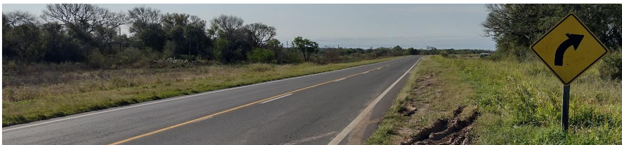
Figura 4. La imagen muestra la señal vertical preventiva de curva a la derecha instalada junto al carril ascendente de la ruta en el tramo previo al lugar de ocurrencia del suceso. Fuente: JST, 2023
