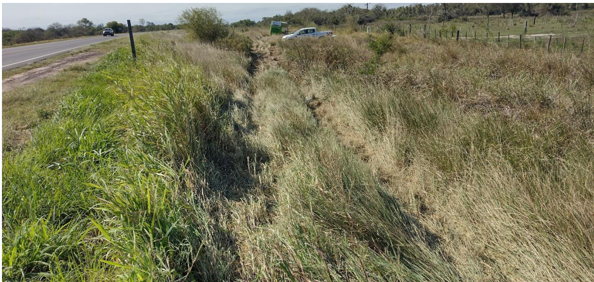
Figura 12. Vista de la continuidad de las marcas de neumático producidas por el ómnibus al descender por el talud y adentrarse al terreno aledaño. Fuente: JST, 2023
