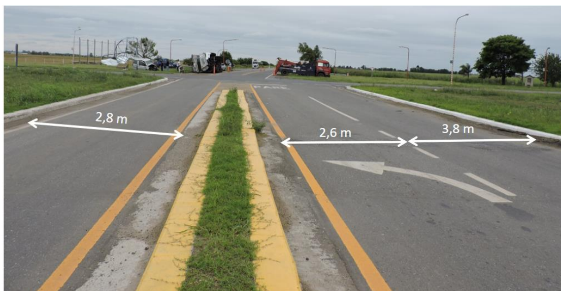
Figura 3. Medidas relevadas en la RP 10. Vista desde Bernardo de Irigoyen hacia la intersección con RP 80. Fuente: JST, 2023
