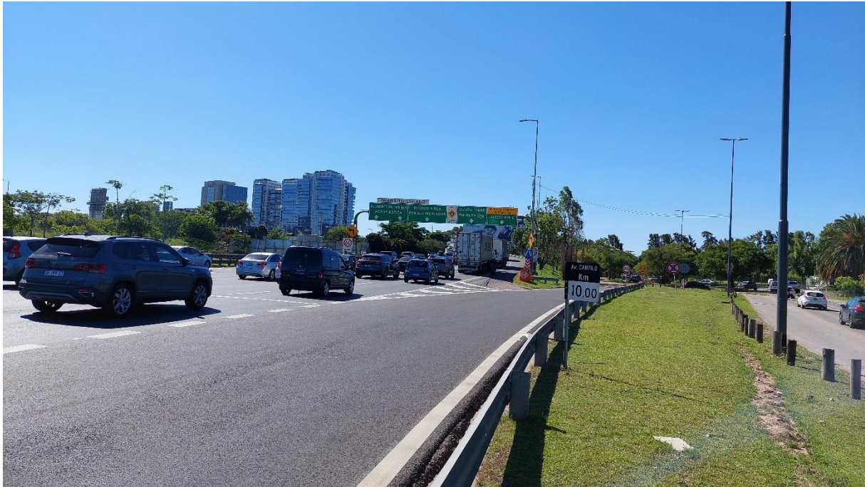
Figura 5. Vista de la calzada en sentido norte en la zona previa al suceso y rampa de salida en dirección al Parque de los niños. Fuente JST, 2023
