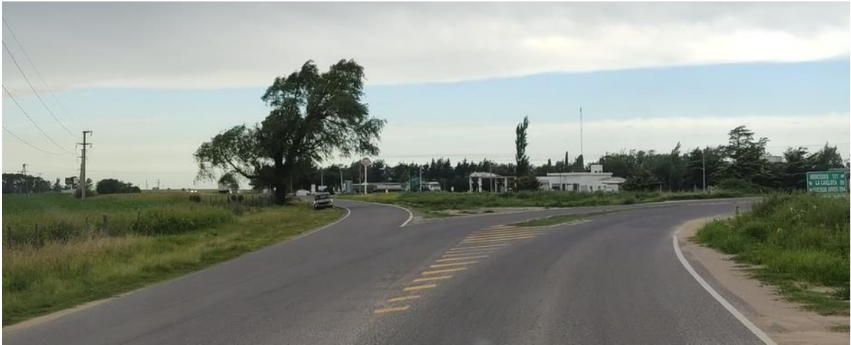
Figura 5. Vista de la RN 36 desde el carril descendente, en el sentido de avance del Vehículo 1. Se observa la canalización de sentidos por isletas, la demarcación horizontal y el inicio de una curva hacia la derecha para quienes se incorporarán a la RN 8. Fuente: JST, 2024
