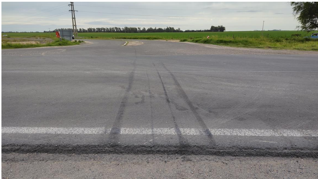
Figura 14. Vista en sentido opuesto al desplazamiento del ómnibus, donde se observan huellas de neumático atravesando la RN 8. Fuente: JST, 2024
