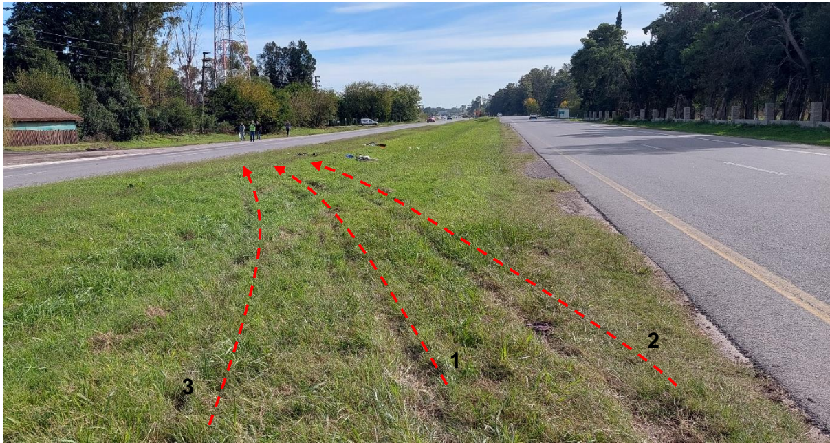
Figura 20. Huellas de derrape previo al cambio de pendiente. Fuente: JST, 2024
