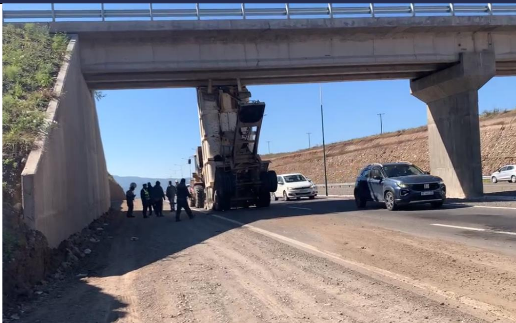
Figura 1. Posición final del semirremolque con batea luego del choque contra el puente vehicular. Fuente: Página de Facebook de diario digital Que Pasa Salta , 2024
