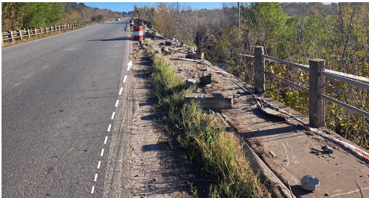
Figura 14. Vista y señalamiento de la huella de neumático producida por la unidad sobre la vía con dirección hacia el paso peatonal. Fuente: JST, 2024
