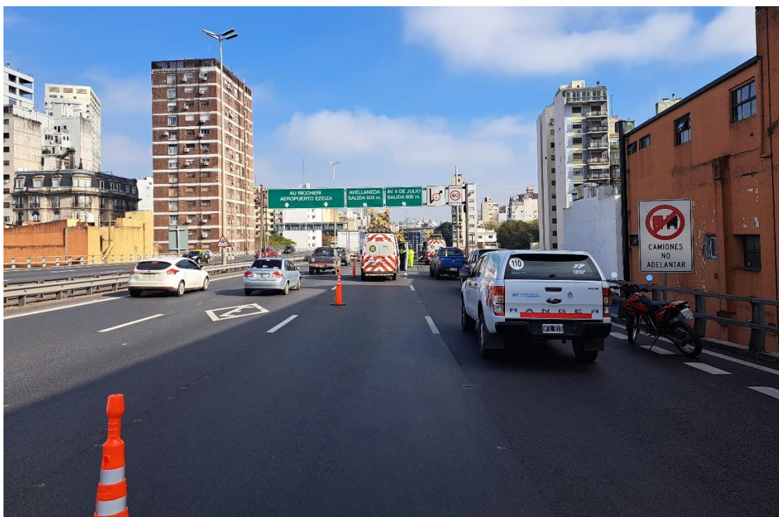
Figura 3. Fotografía de la infraestructura vial de la zona previa al suceso, con sentido hacia la autopista Perito Moreno. Fuente: JST, 2024
