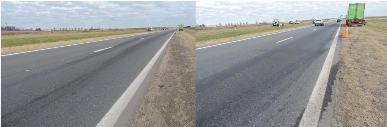
Figura 10. Marcas de fluido sobre la calzada y sobre la banquina. Fuente: JST, 2024
