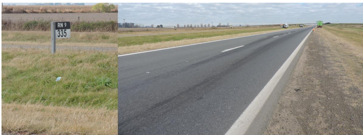
Figura 3. A la izquierda, indicador kilométrico 335. A la derecha, vista de la calzada ascendente, con señalización horizontal y banquina externa. Fuente: JST, 2024
