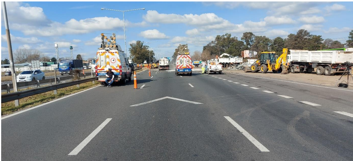
Figura 4. Autopista Ruta Nacional 9, mano de circulación hacia CABA. Fuente: JST, 2024
