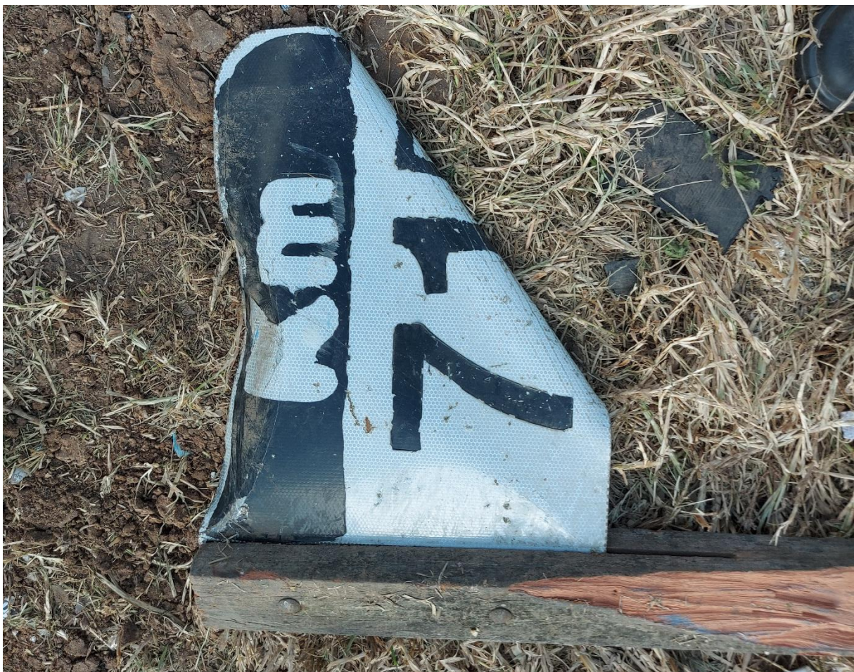
Figura 7. Mojón del kilómetro 71,5 dañado durante el suceso. Fuente: JST, 2024
