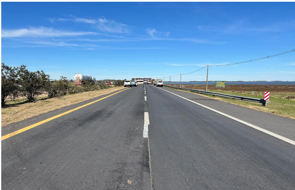
Figura 3. Vista del sentido de circulación del ómnibus donde puede observarse la señalización vertical y horizontal presente. Fuente: JST, 2024
