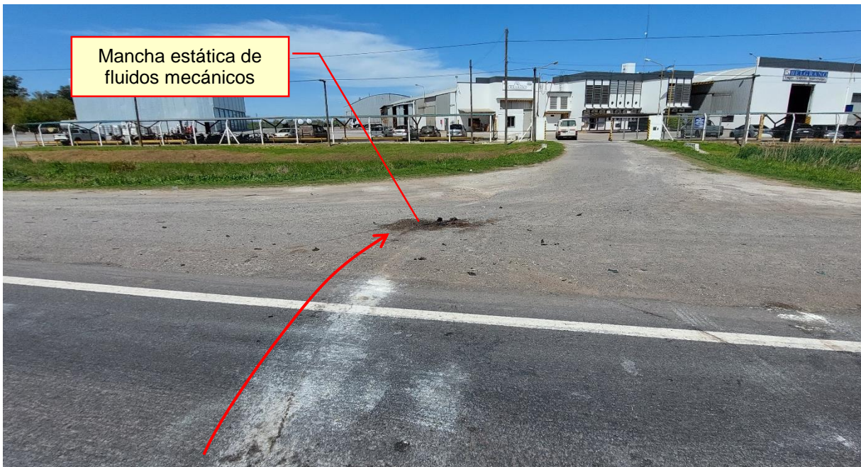
Figura 18. Finalización de mancha dinámica y mancha estática de fluidos mecánicos del Vehículo 1. Fuente: JST, 2024
