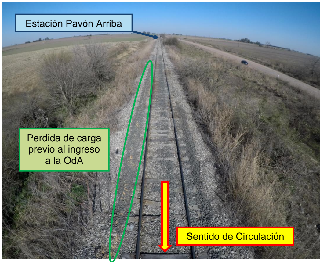
Figura 3. Estado de vía al arribo de investigadores, trecho de vía del descarrilamiento. Fuente: Investigadores y anotaciones JST
