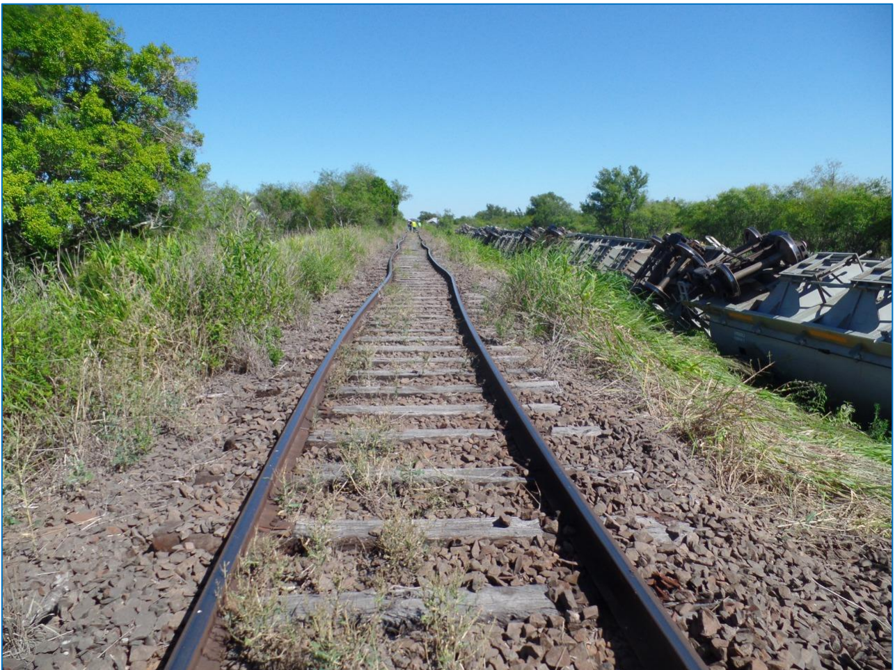
Figura 1- Vista general del descarrilamiento mirando hacia la estación Libertador Gral. San Martín. Fuente: Propia Investigadores DNISF en el lugar del suceso.
