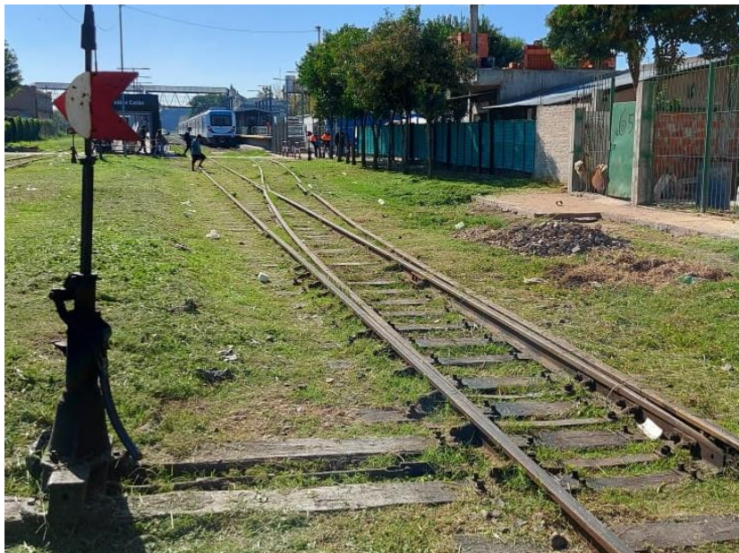
Figura 5 - Aparato de vía N° 26 con su indicación
