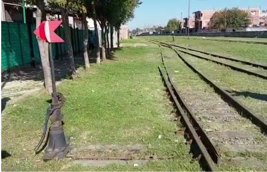
Figura 4 - Mecanismo de accionamiento e indicación de la trampa del suceso al 28/04/2021
