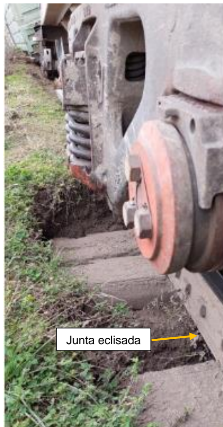
Figura 8. Asentamiento de durmientes en tierra húmeda. Fuente: JST, 2021
