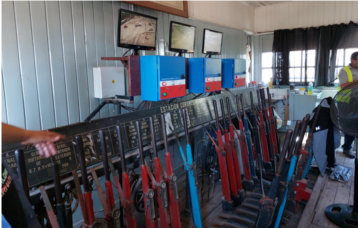
Figura 13. Marco de palancas del Cabín Coronel Aguirre, Fuente: Archivo JST
