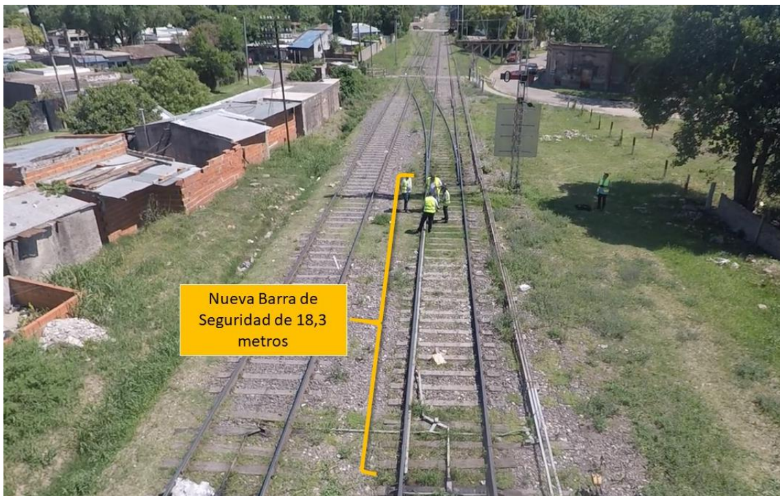
Figura 16. Medición de la nueva barra de seguridad, la misma posee actualmente 18,3 metros de longitud, Fuente Archivo JST
