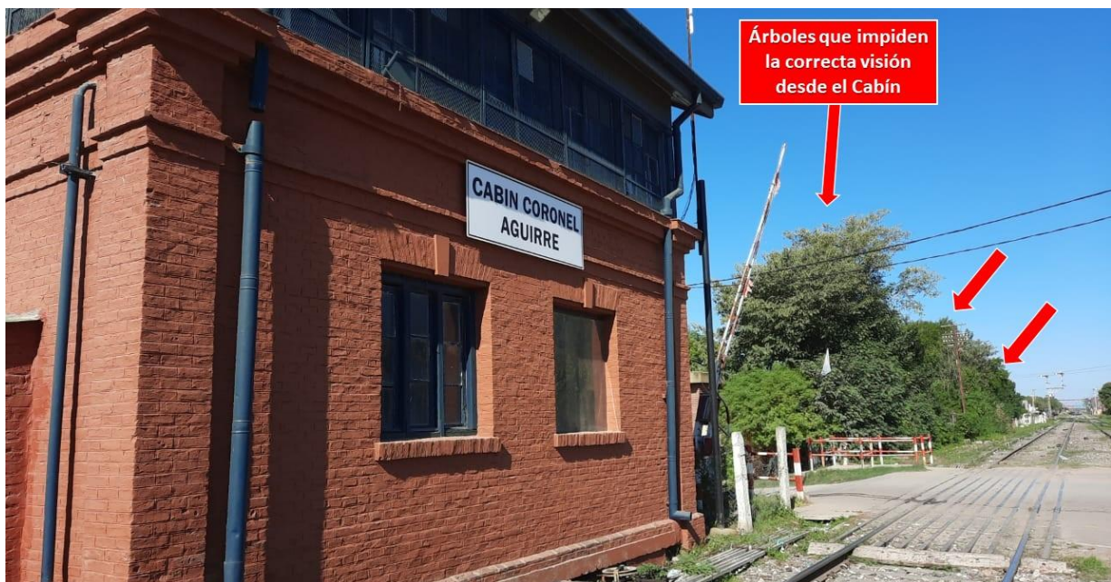
Figura 8. Arboleda que impide la correcta visión desde el Cabín, imagen 1° visita, Fuente: Archivo JST
