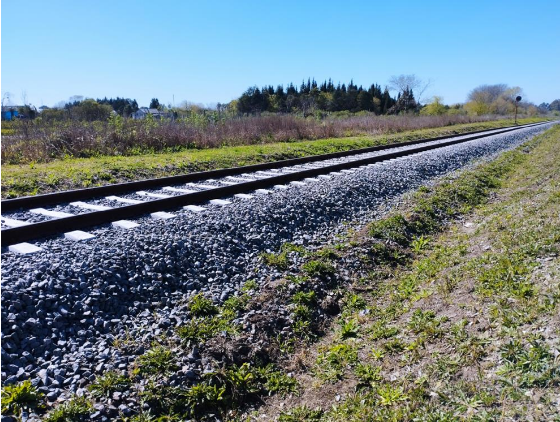
Figura 6. Tramo de vía renovada en la zona del descarrilamiento del tren 2004. Fuente JST, 2022
