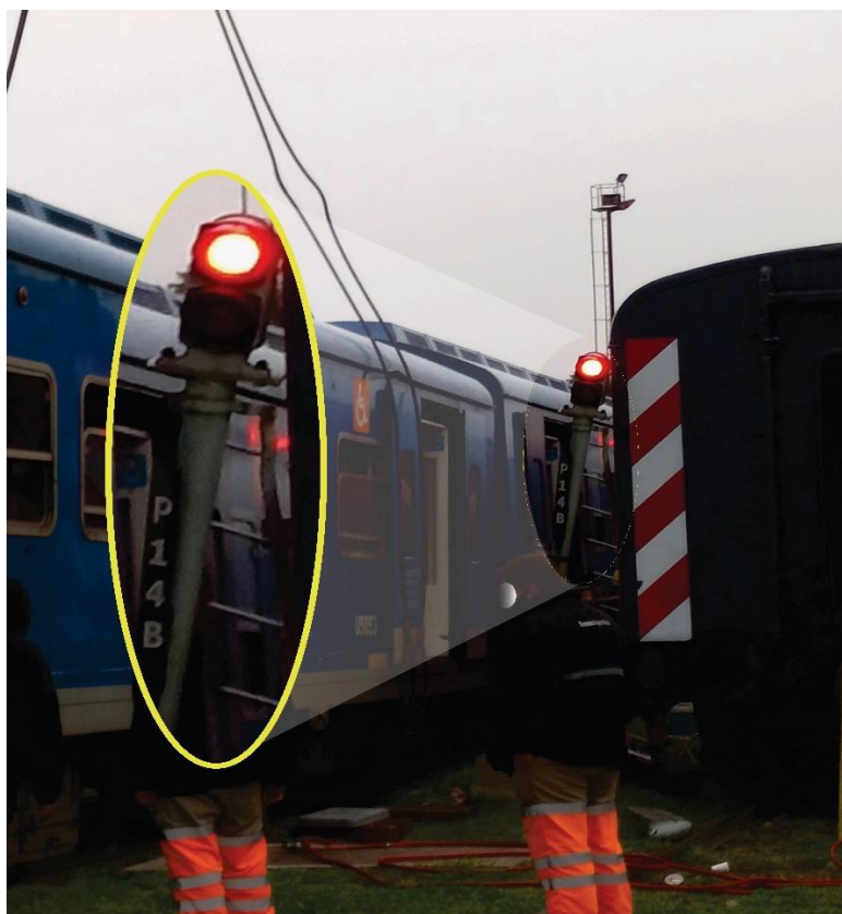
Figura 9. Inclinación de la señal P14B. Fuente: JST, 2021
