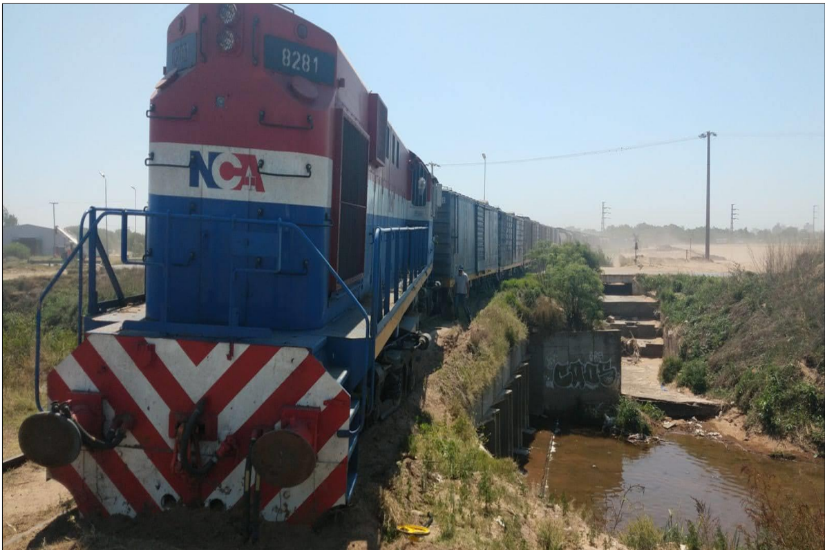
Figura 1. Tren 110/496 descarrilado sobre una alcantarilla ferroviaria. Fuente: JST, 2021
