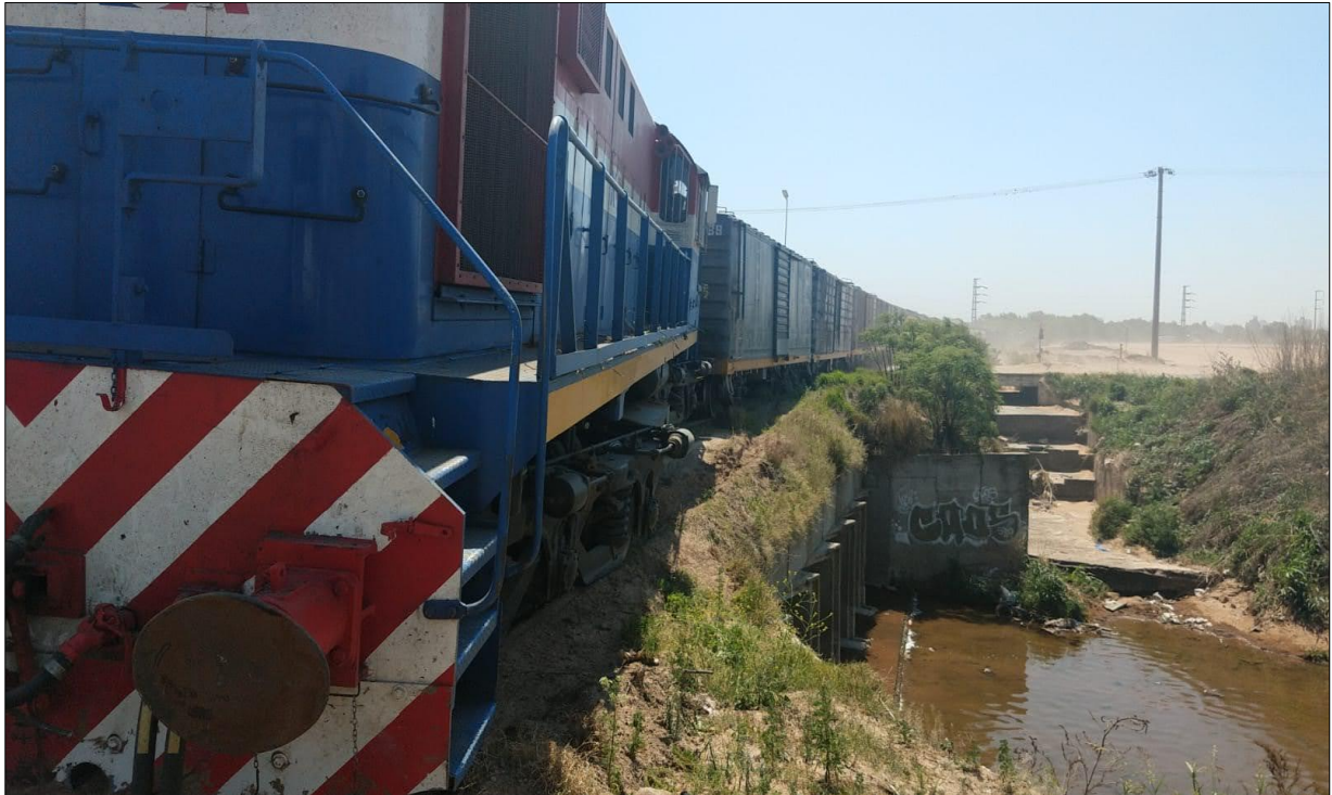
Figura 3. Locomotora sobre el borde de la alcantarilla. Fuente: JST, 2021
