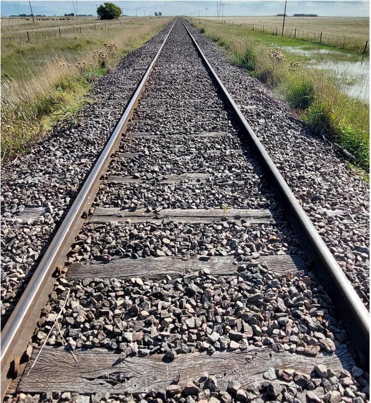
Figura 7. Superestructura de vía posterior a la zona del descarrilamiento. Fuente: JST, 2022
