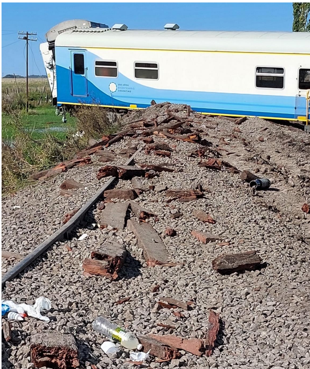
Figura 9. Superestructura de vía afectada por el descarrilamiento. Fuente: JST, 2022
