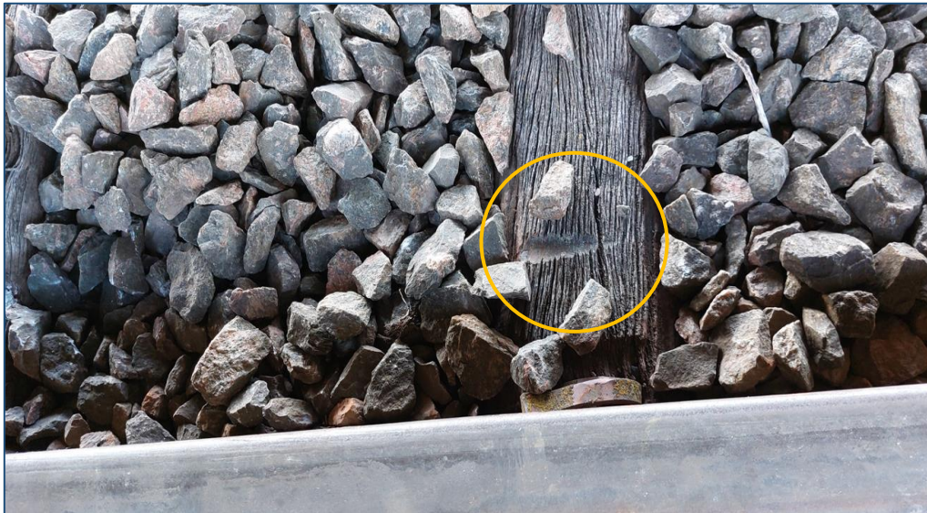
Figura 12. Marcas de pestañas sobre el durmiende. Fuente: JST, 2022
