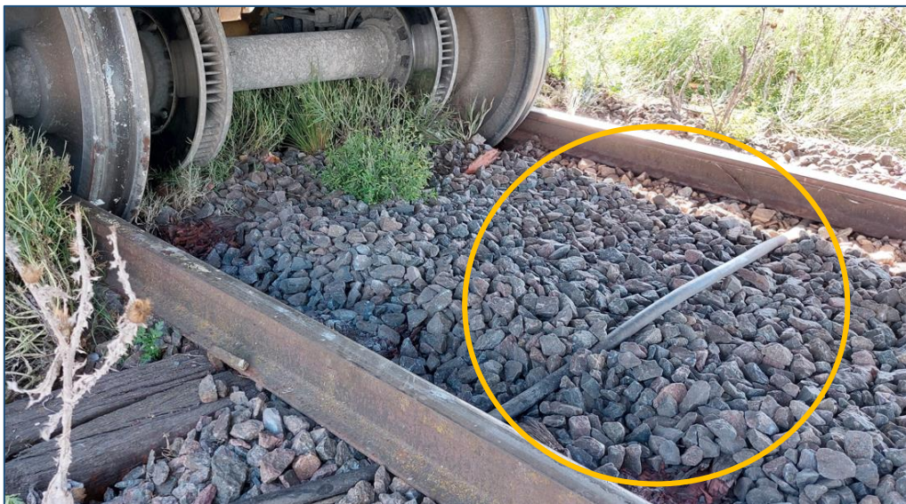
Figura 4. Manguera que atraviesa la vía sobre el balasto de piedra. Fuente: JST, 2022
