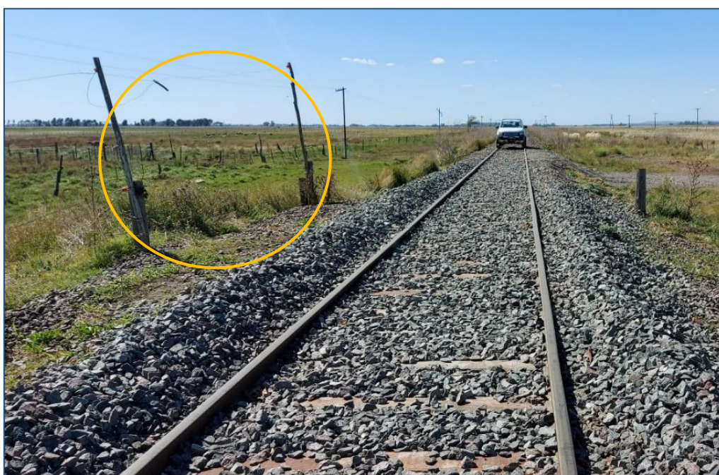
Figura 2. Postes sin alambrado en el sector del suceso. Fuente: JST, 2022
