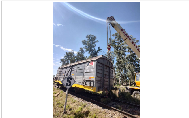
Fig.1. Izaje de uno de los vagones descarrilados. Fte: JST
