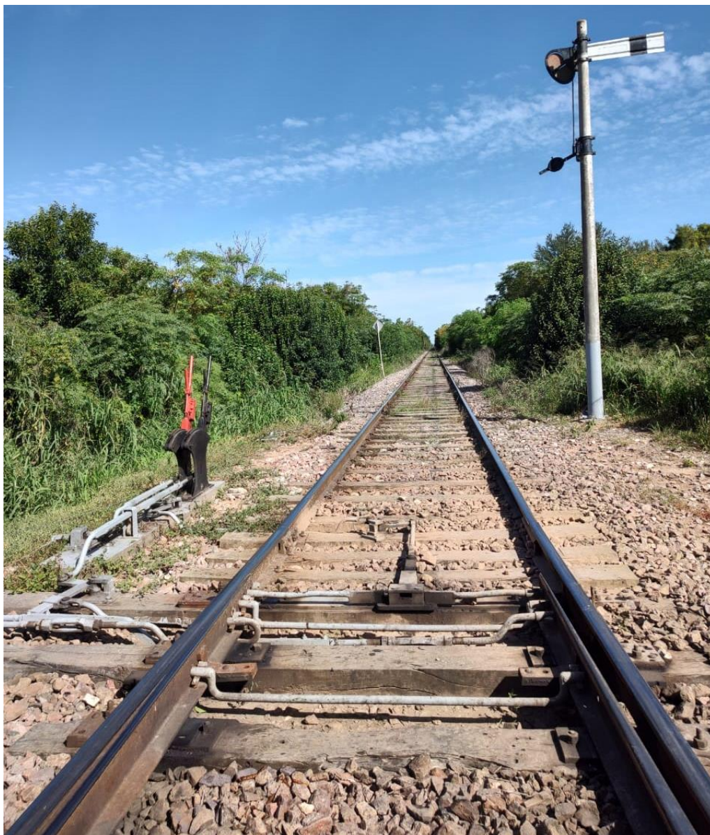
Figura 1. Indicador de posición de ADV presente en el ingreso del desvío, lado sur. Fuente: JST, 2022
