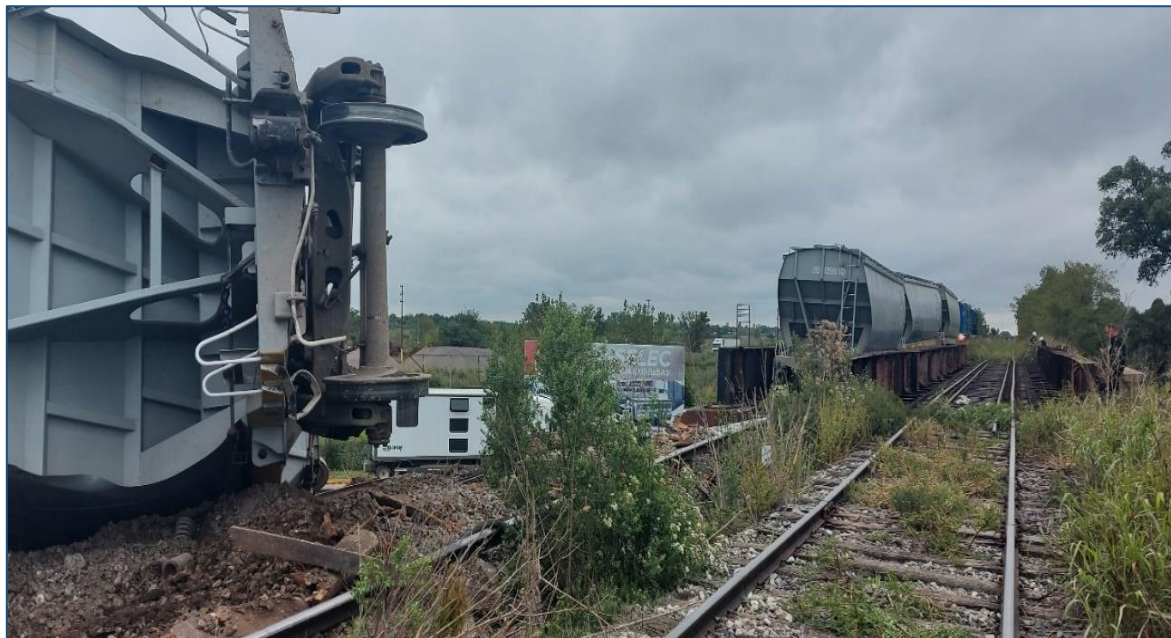
Figura 1. Vista del descarrilamiento en sentido de la marcha del tren. Fuente: JST, 2022.
