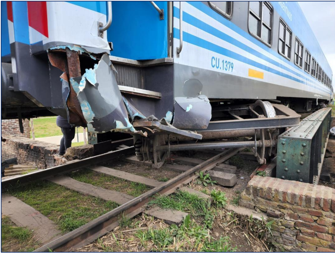
Figura 9. Daños en el material rodante ocasionados por el impacto contra una alcantarilla.
