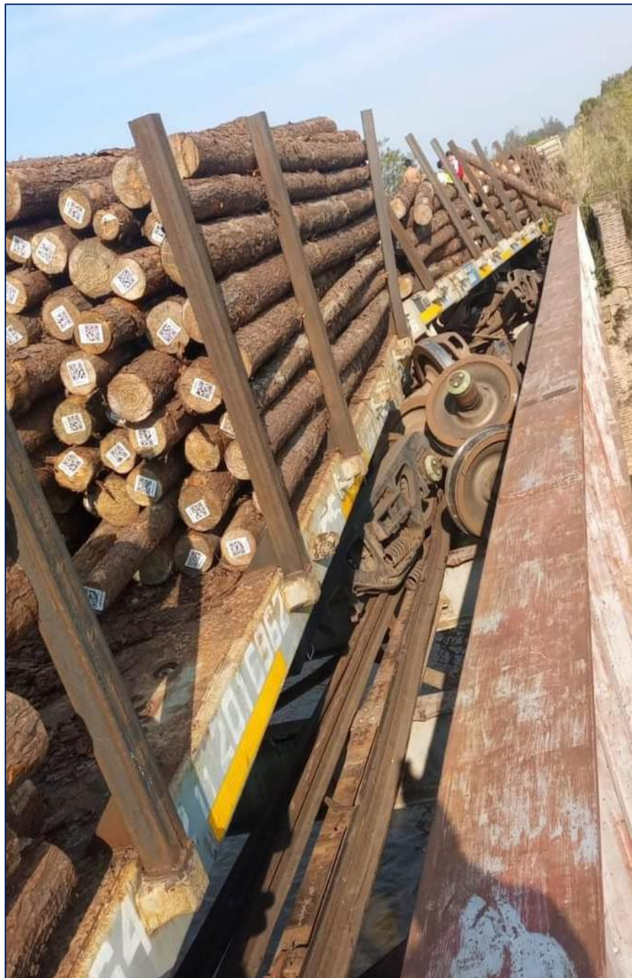
Figura 12. Desprendimiento de pares montados sobre el tramo metálico del puente ferroviario de Monte Caseros. Fuente: Crónica Ferroviaria , 2023
