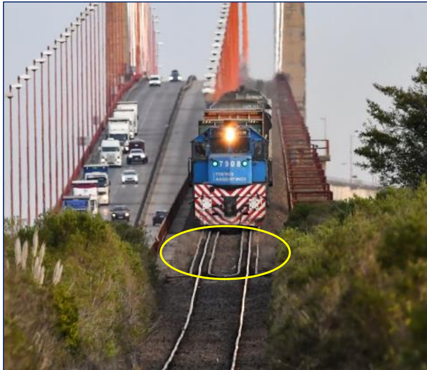
Figura 14. Contrarrieles internos y externos en uno de los puentes del Complejo ferroviario Zárate–Brazo Largo. Fuente: Railpictures.net , 2024
