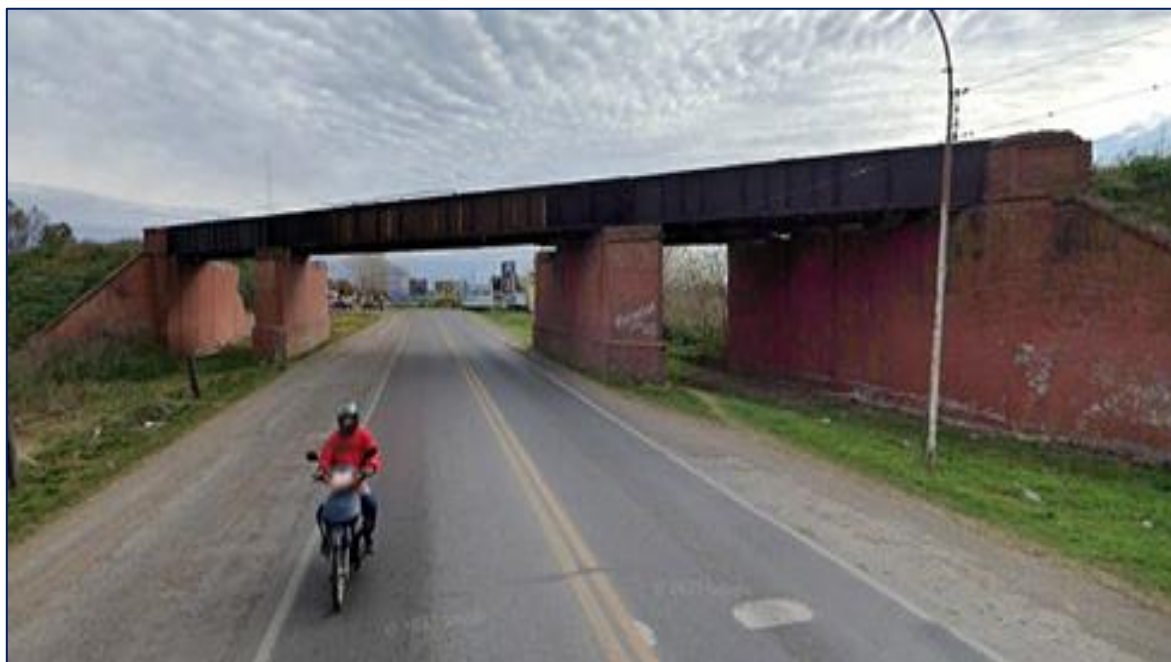
Figura 2. Puente ferroviario de Pérez, visto desde la Ruta Nacional 33. Fuente: Google Earth, 2022
