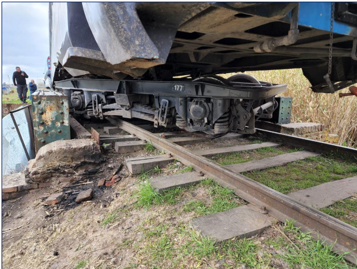
Figura 8. Bogie del tren de pasajeros descarrilado sobre una alcantarilla.
