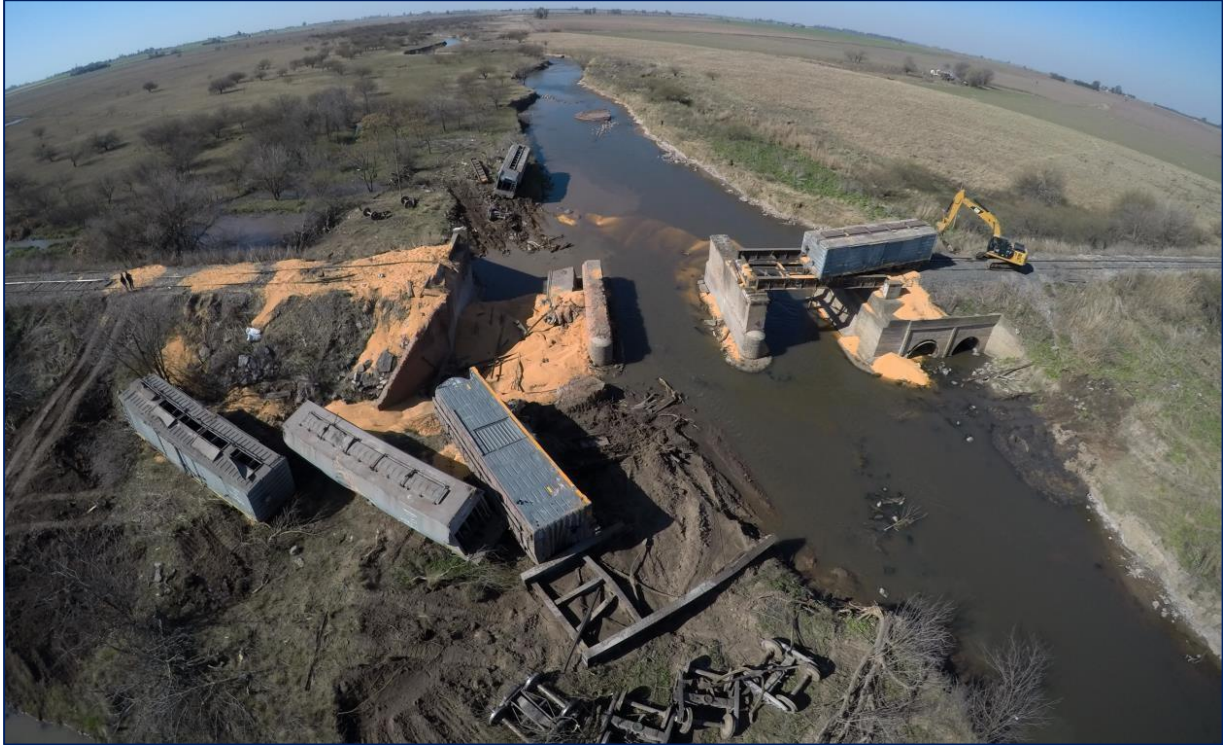
Figura 5. Posición final de los vagones descarrilados del tren H68. Fuente: JST, 2020
