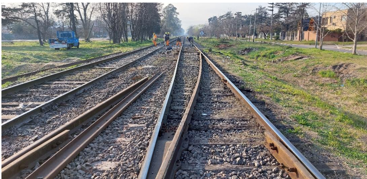
Figura 5. Vía ascendente con el ADV desarmado. Fuente: JST, 2022
