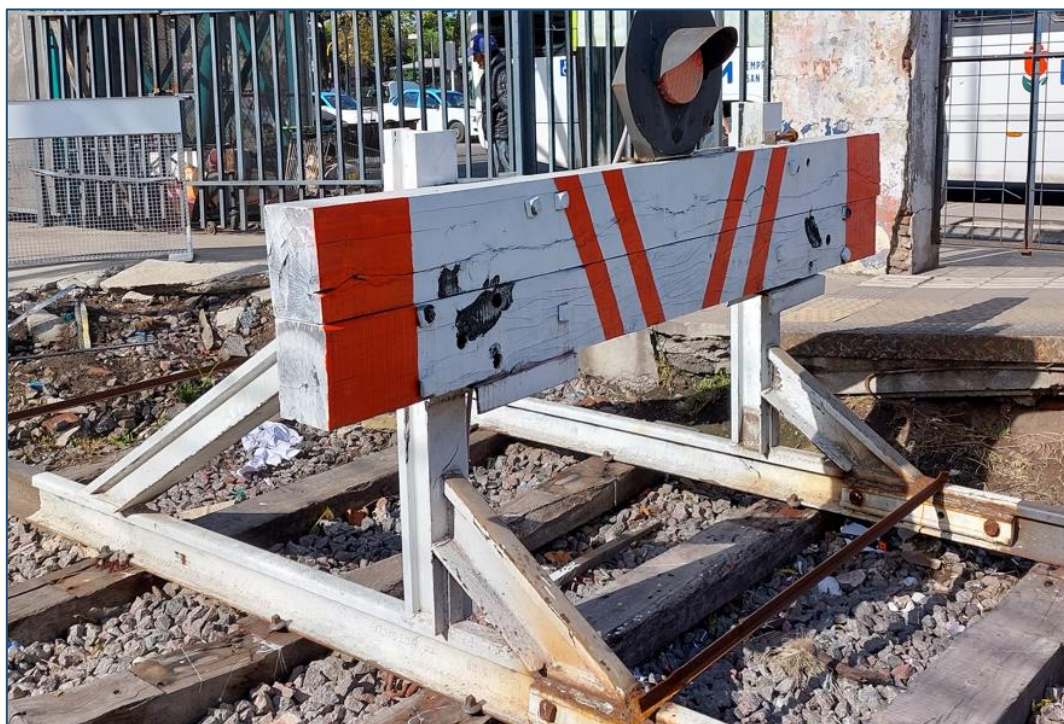
Figura 4. Marcas de impacto en el FDV de la vía 5. Fuente: JST, 2023
