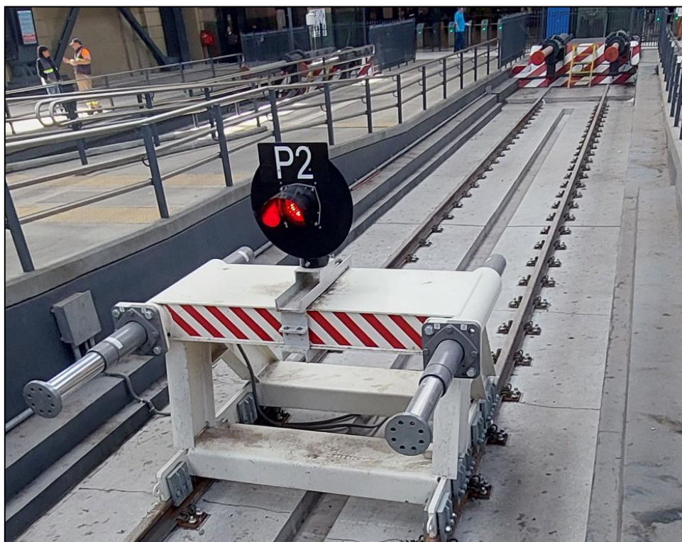
Figura 42. FDV de fricción e hidráulico en la vía 2, estación Retiro de la LM. Fuente: JST, 2024
