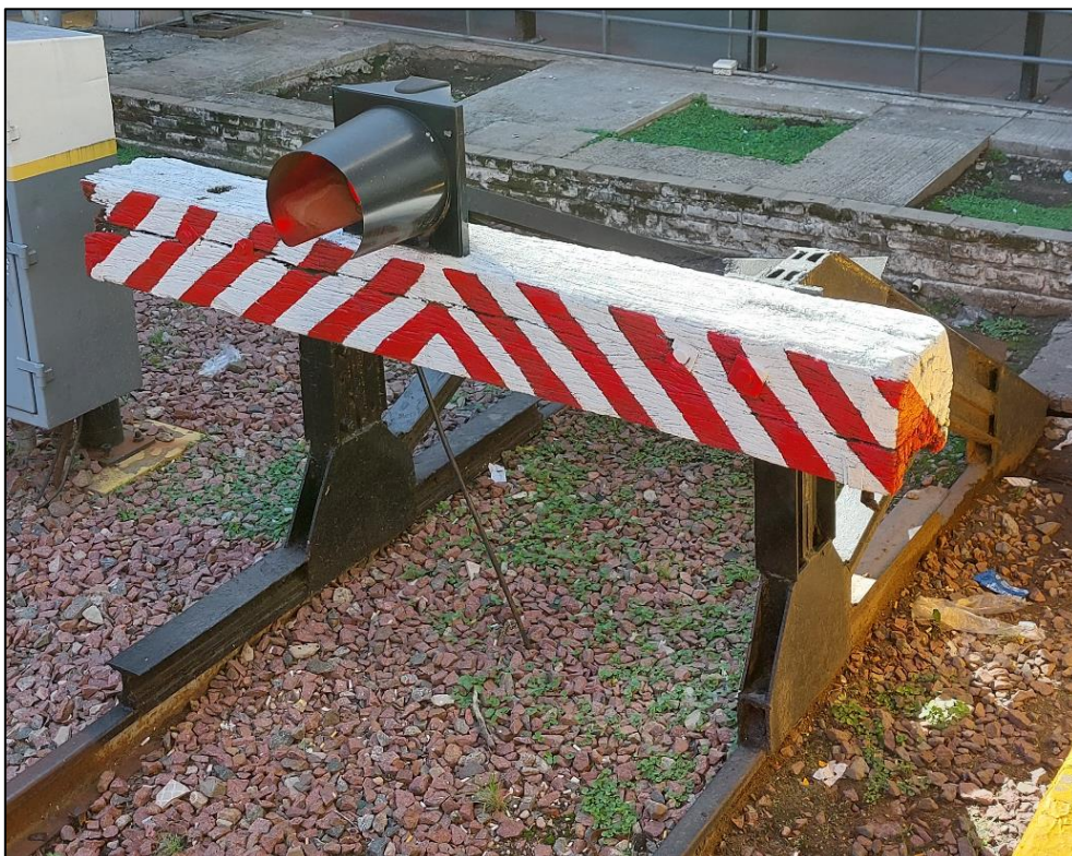
Figura 26. FDV de la vía 5, estación F. Lacroze. Fuente: JST, 2024
