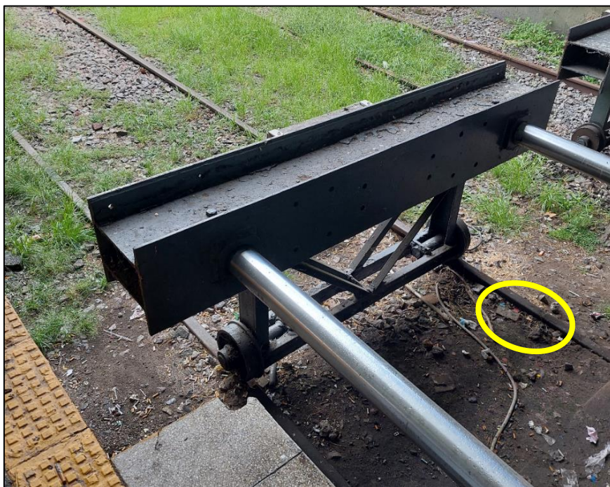
Figura 10. Presencia de tierra junto a la cara interna de riel, estación Once. Fuente: JST, 2024
