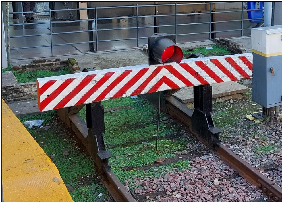
Figura 25. FDV de la vía 4, estación F. Lacroze. Fuente: JST, 2024
