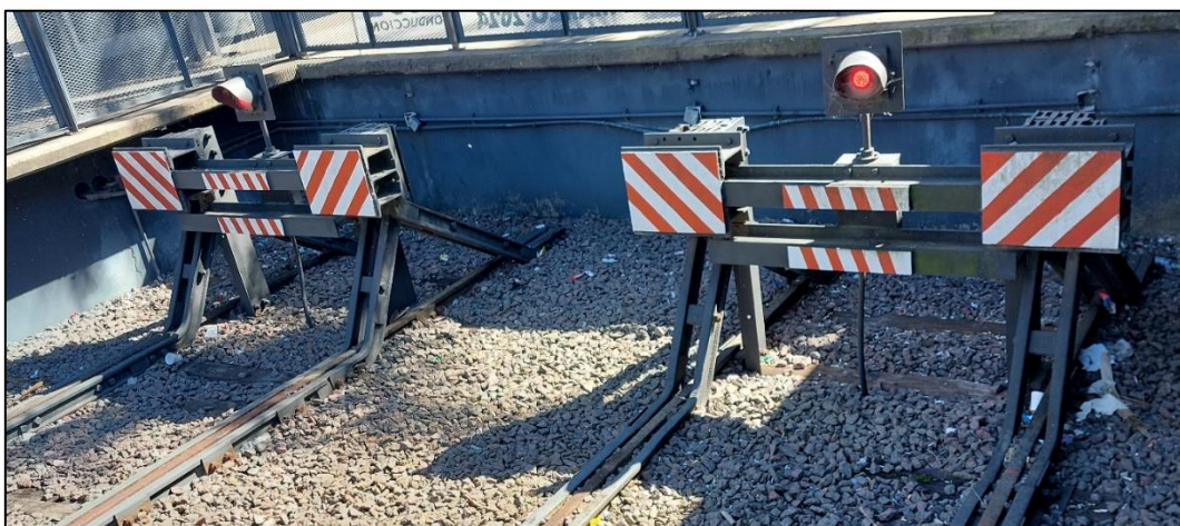
Figura 46. FDV en las vías de la estación Tigre, lado norte. Fuente: JST, 2024
