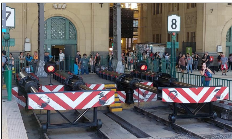
Figura 18. FDV de las vías 7 y 8, estación Constitución. Fuente: JST, 2024
