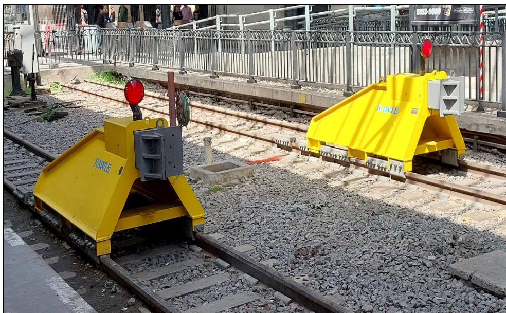
Figura 30. FDV de las vías 5 y 6, estación Retiro de la LBN Fuente: JST, 2024
