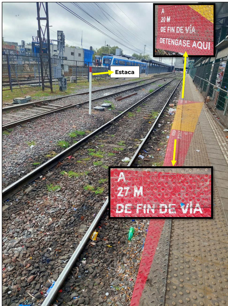
Figura 6. Estaca en la entrevía y triángulo con referencias del FDV en la periferia de la vía 5 de la estación Merlo. Fuente: JST, 2023
