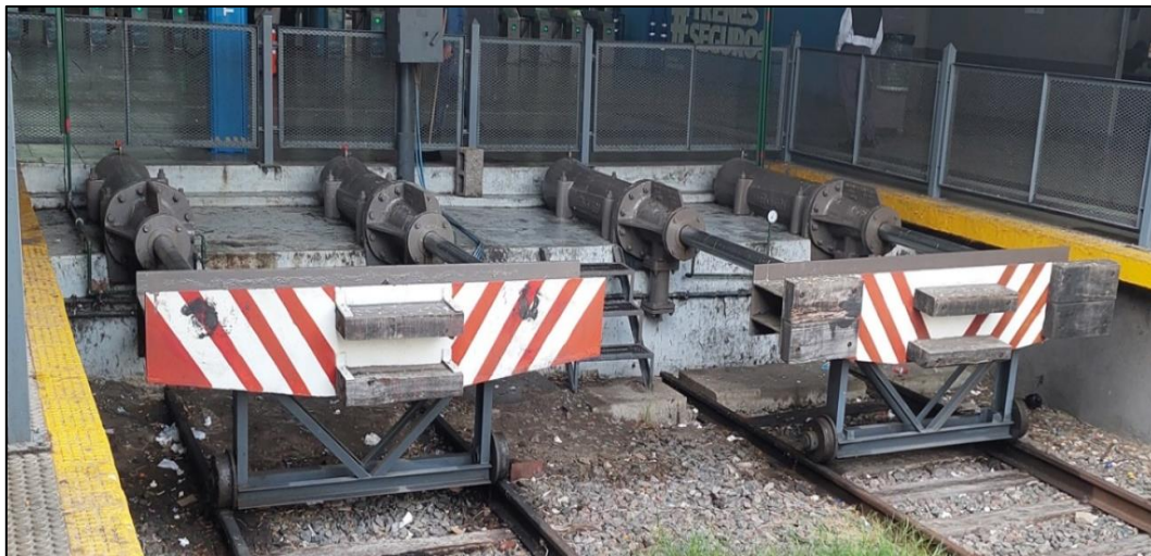
Figura 7. FDV de las vías 1 y 2 de la estación Once. Fuente: JST, 2024
