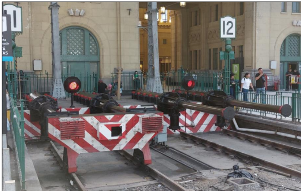
Figura 20. FDV de las vías 11 y 12, estación Constitución. Fuente: JST, 2024
