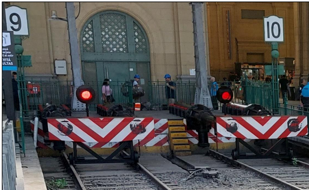
Figura 19. FDV de las vías 9 y 10, estación Constitución. Fuente: JST, 2024
