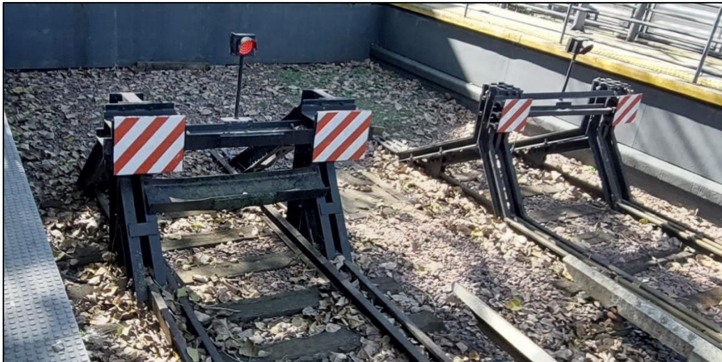
Figura 44. FDV en las vías de la estación Mitre. Fuente: JST, 2024
