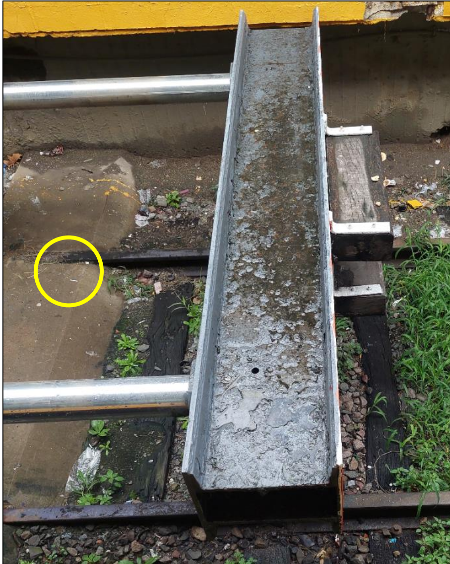
Figura 12. Viga superior y superficie de concreto. Fuente: JST, 2024
