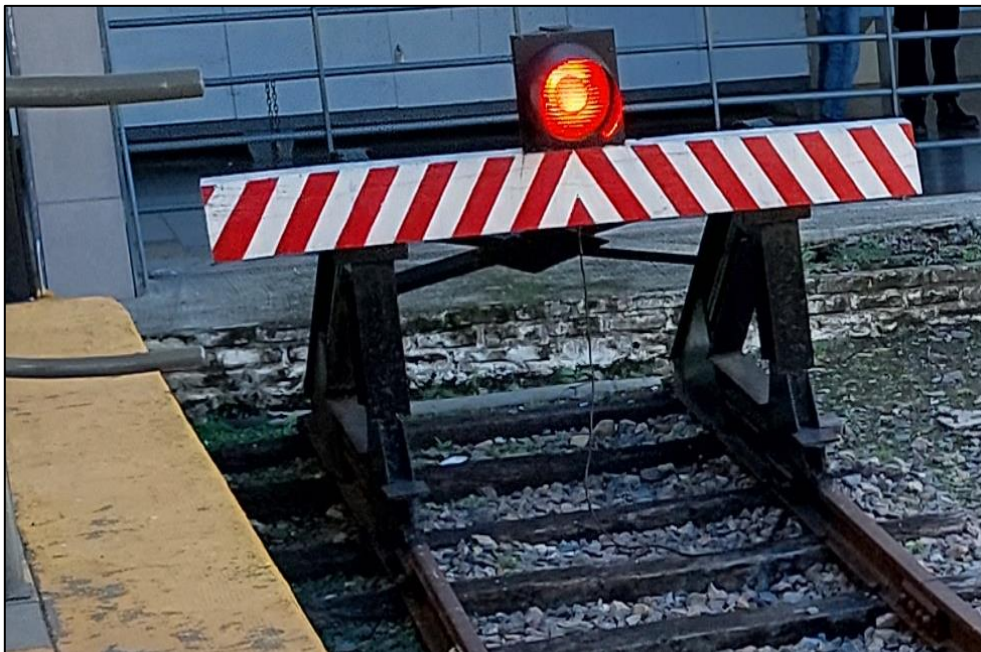
Figura 23. FDV de la vía 2, estación F. Lacroze. Fuente: JST, 2024
