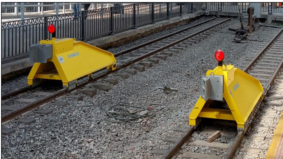
Figura 32. FDV de las vías 1 y 2, estación Retiro de la LBN. Fuente: JST, 2024
