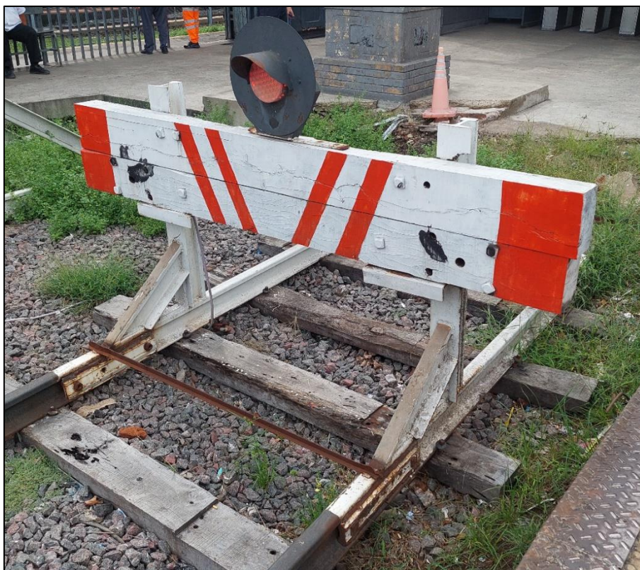
Figura 13. FDV de la vía 5, estación Merlo. Fuente: JST, 2024
