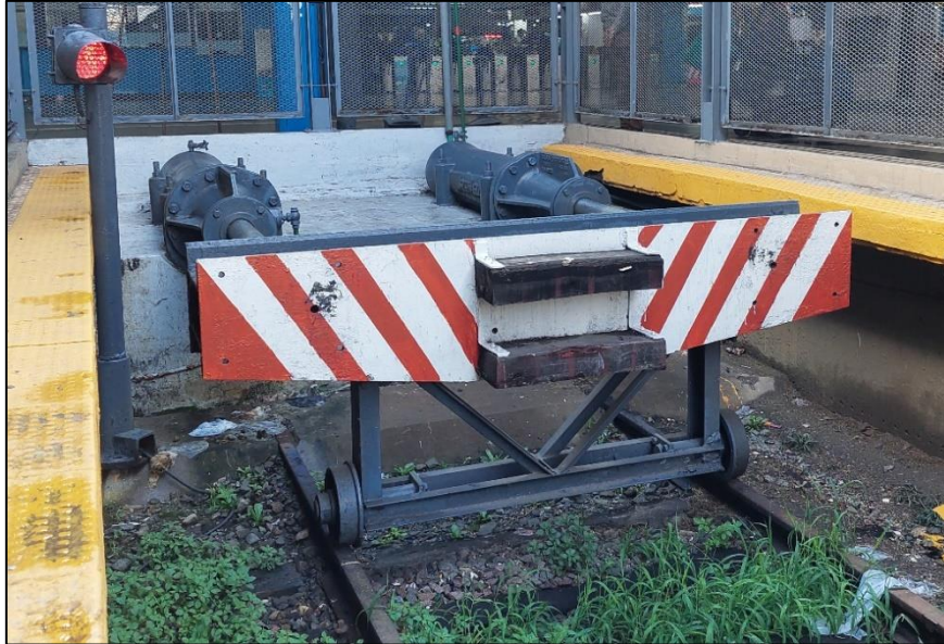
Figura 11. FDV de la vía 5, estación Once. Fuente: JST, 2024
