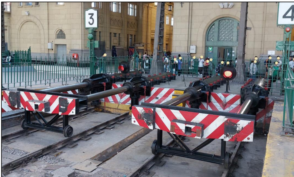
Figura 16. FDV de las vías 3 y 4, estación Constitución. Fuente: JST, 2024
