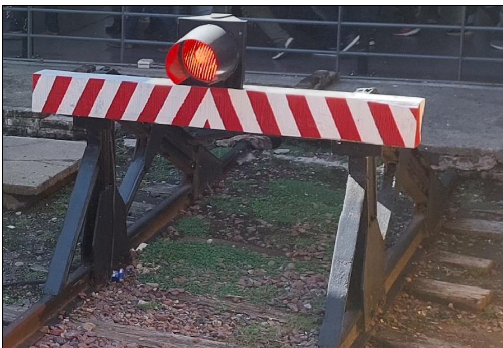
Figura 24. FDV de la vía 3, estación F. Lacroze. Fuente: JST, 2024
