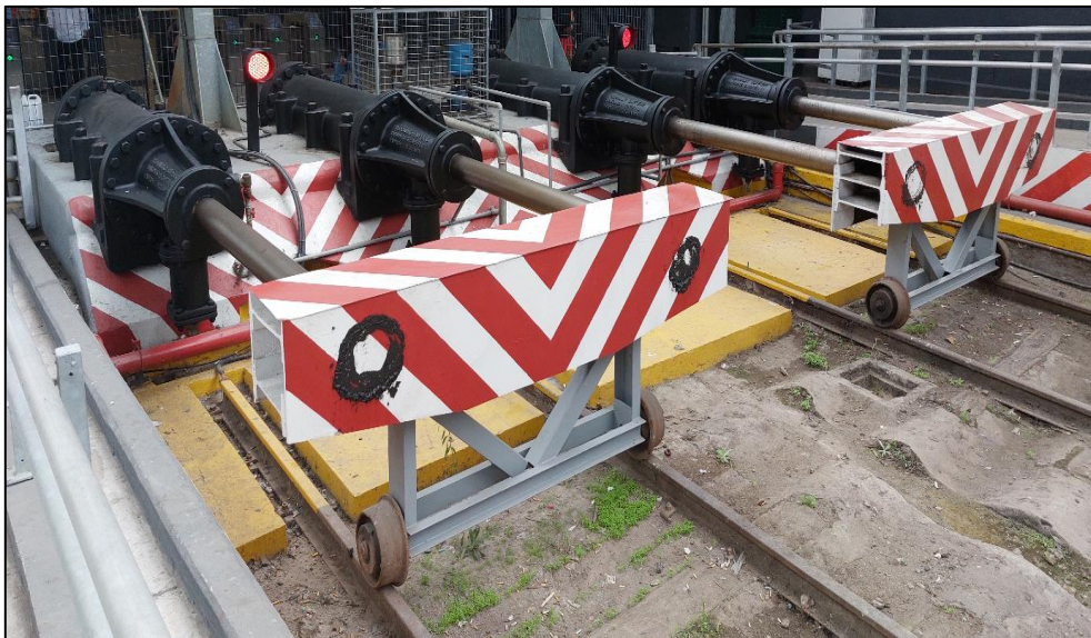
Figura 22. FDV de ambas vías de la estación La Plata. Fuente: JST, 2024
