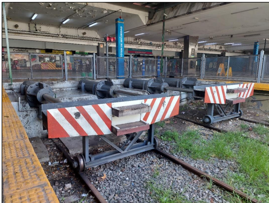
Figura 8. FDV de las vías 3 y 4 de la estación Once. Fuente: JST, 2024
