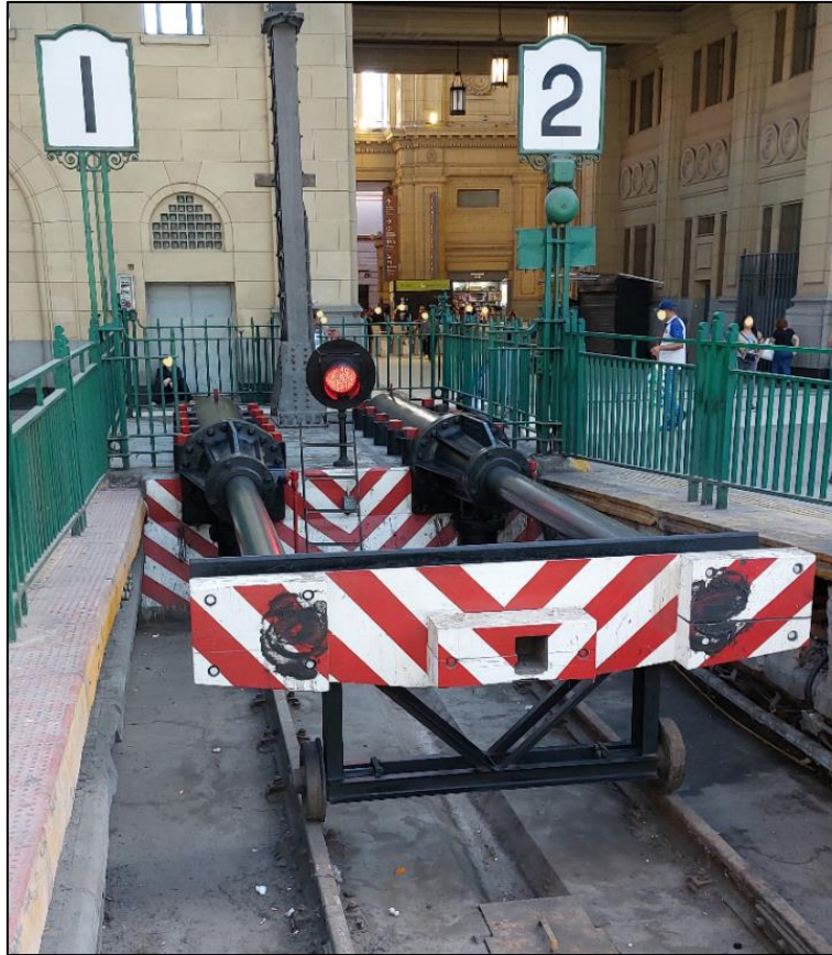
Figura 15. FDV entre andenes 1 y 2, estación Constitución. Fuente: JST, 2024
