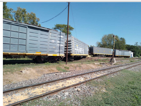
Fig. 4. Vista parcial de los vagones descarrilados
