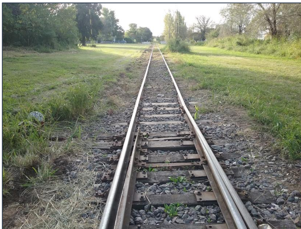
Figura 9. Final del ADV previo al lugar del suceso. Fuente: JST, 2023
