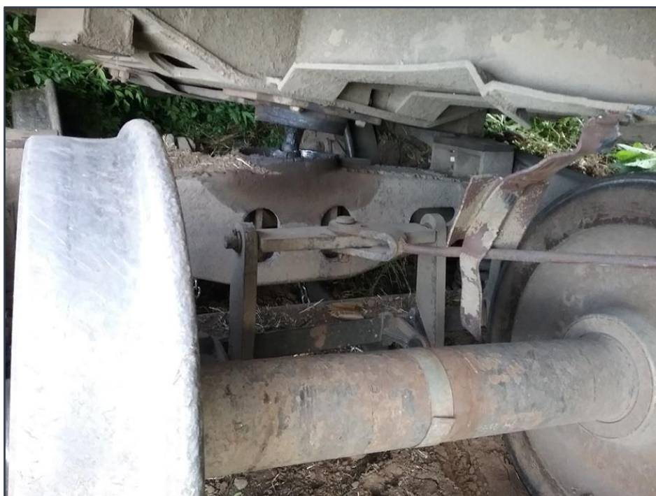
Figura 6. Bogie delantero del vagón 325076. Fuente: JST, 2023
