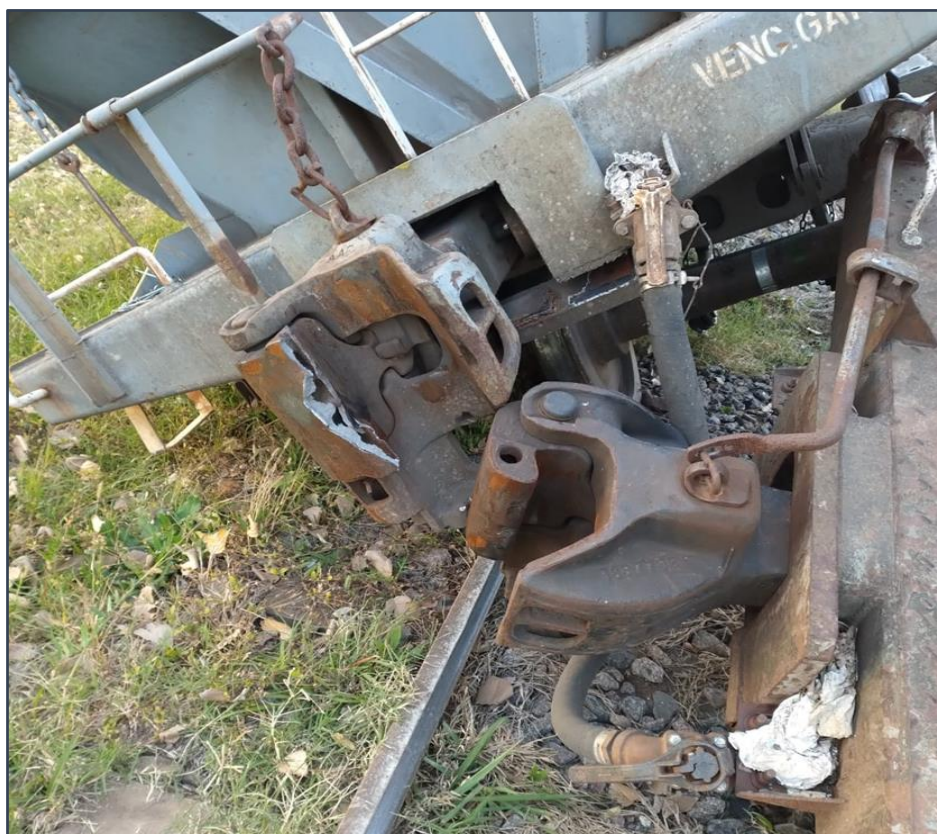
Figura 3. Enganche fracturado del vagón 325514. Fuente: JST, 2023
