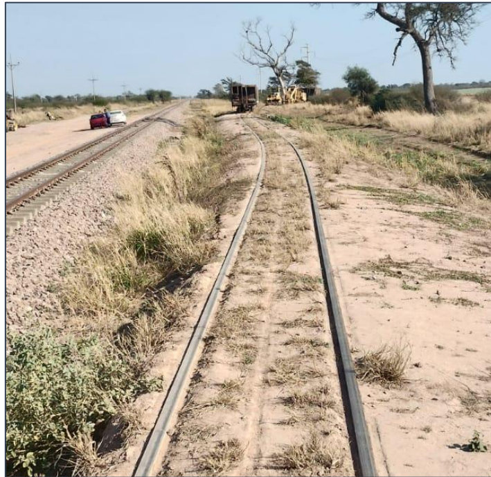
Figura 3. Imagen de la infraestructura del desvío. Fuente: JST, 2023
