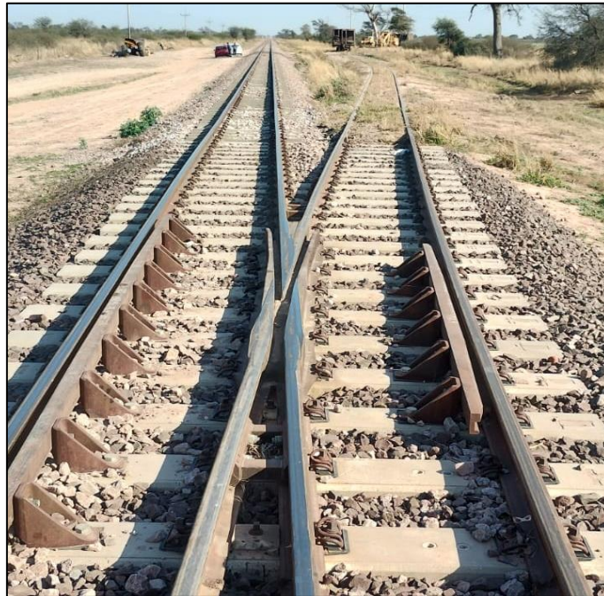
Figura 2. Imagen del ADV de ingreso al desvío particular. Fuente: JST, agosto 2023
