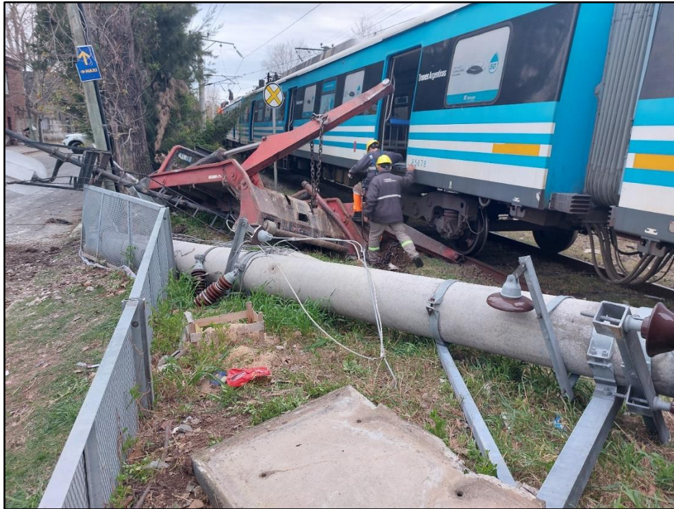
Figura 4. Columna derribada del sistema de electrificación. Fuente: JST, 2023
