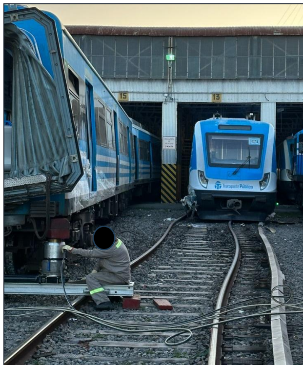
Figura 1. Vista general de las formaciones RC19 y RC12 en proceso de encarrilamiento en el depósito de Castelar. Fuente: JST, 2023
