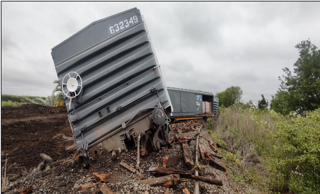
Figura 2. Distribución zigzagueante de los vagones con respecto al eje de la vía. Fuente: JST, 2023
