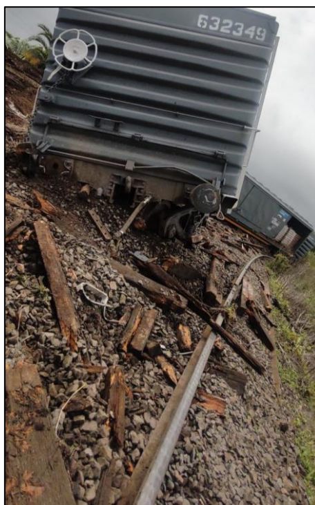
Figura 7. Daños en la superestructura de vía ocasionados por el suceso. Fuente: JST, 2023
