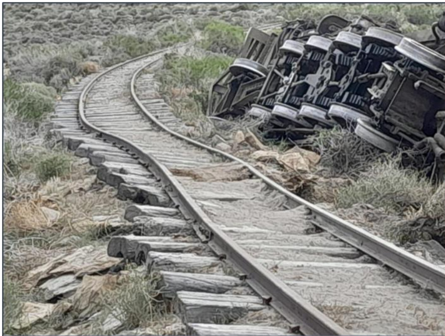
Figura 2. Estado final del tren. Fuente: TPSA
