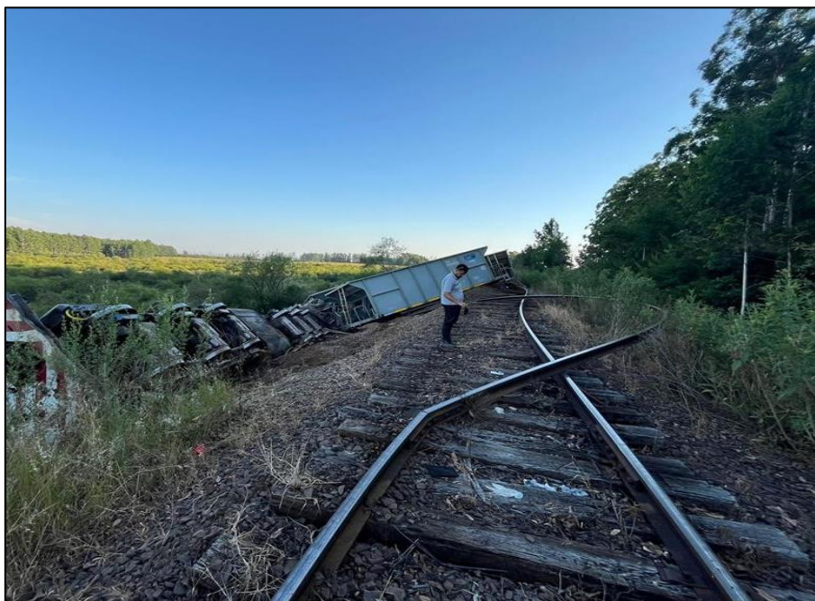
Figura 5. Daños en la infraestructura de vía. Fuente: JST, 2024
