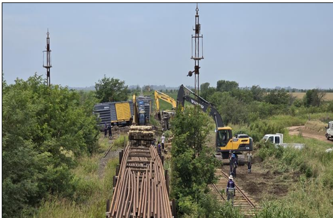
Figura 2. Tareas de encarrilamiento de vagones y reparación de la superestructura de vía.
