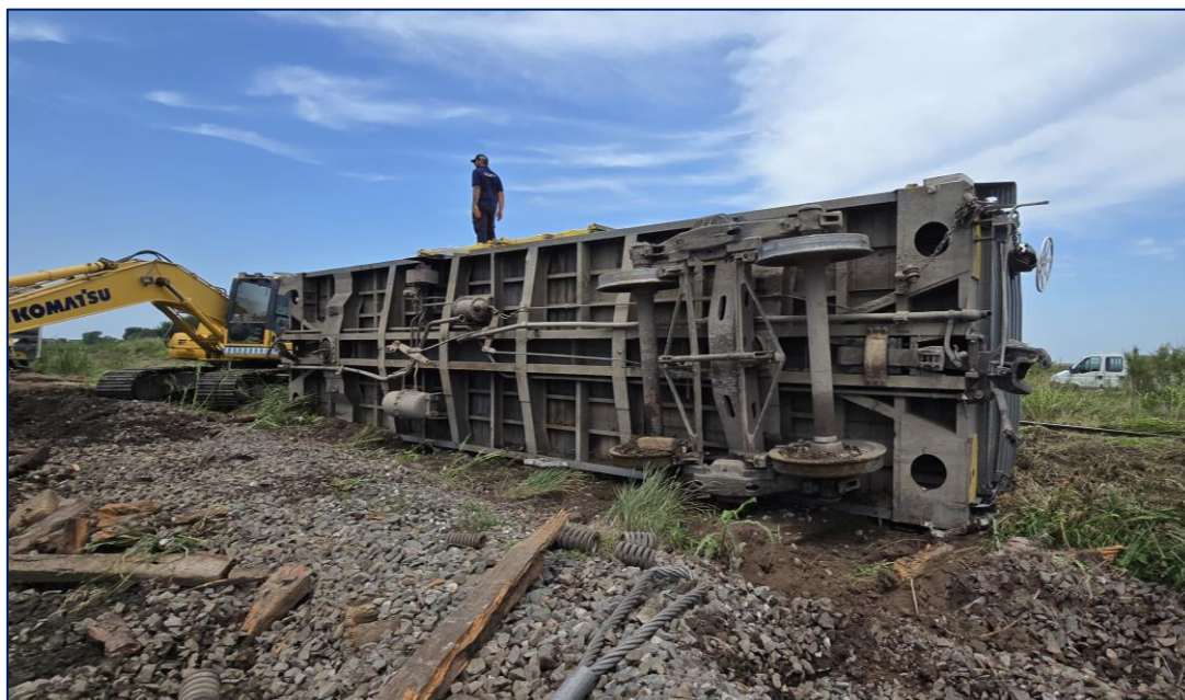
Figura 4. Vagón volcado con desprendimiento de bogie y resortes de suspensión. Fuente: JST, 2024
