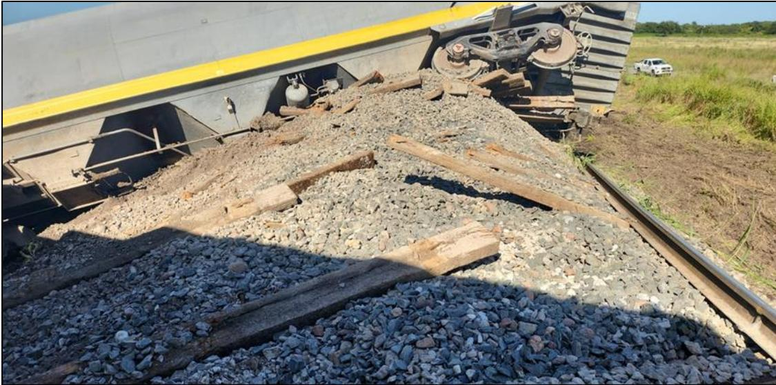
Figura 8. Daños en la infraestructura de vía. Fuente: JST, 2024
