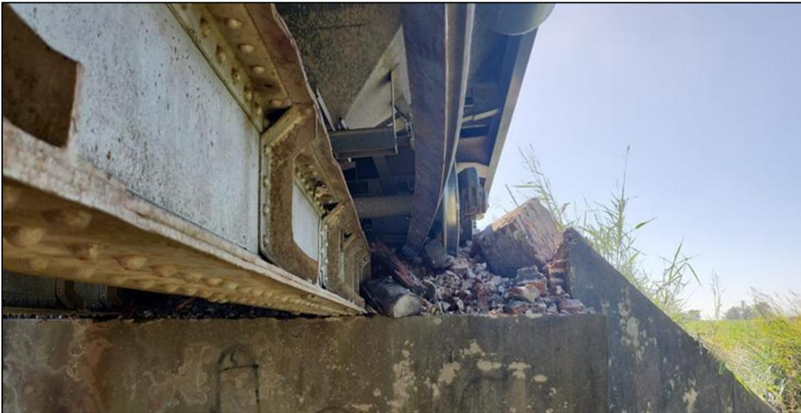
Figura 9. Alcantarilla afectada por el impacto de uno de los vagones descarrilados.
