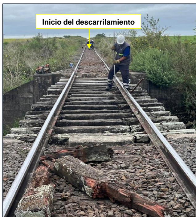
Figura 7. Personal de vías y obras trabajando en la superestructura afectada por el descarrilamiento. Fuente: JST, 2024
