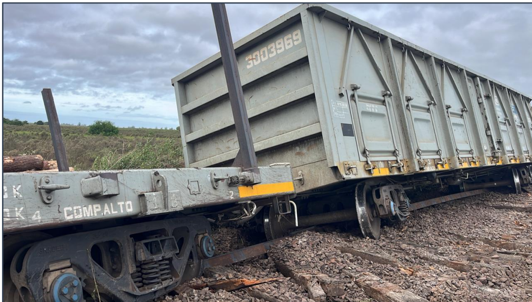
Figura 6. Estado de la superestructura de vía y de los vagones afectados por el descarrilamiento.
