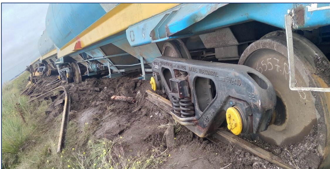
Figura 1. Imagen de los vagones afectados por el descarrilamiento, en sentido oeste.
