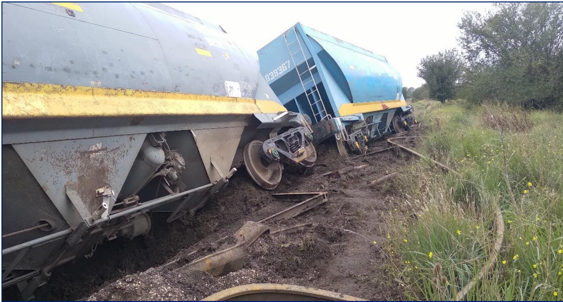
Figura 7. Vista general de los daños en la superestructura de vía ocasionados por el suceso.
