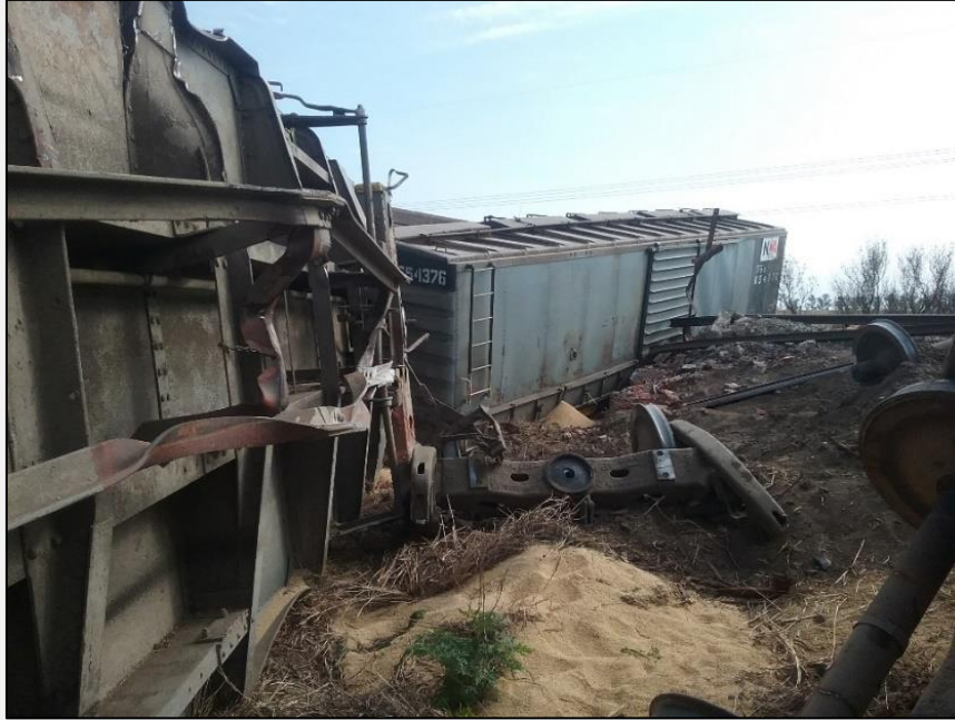
Figura 1. Daños graves ocasionados a la infraestructura de vía y al material rodante, kilómetro 532. Fuente: JST, 2024
