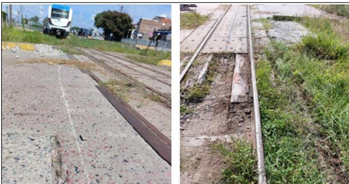
Figura 6. Marcas en el pavimento y en el suelo, paralelas a la vía, que evidencian el recorrido de los pares montados descarrilados. Fuente: JST, 2025
