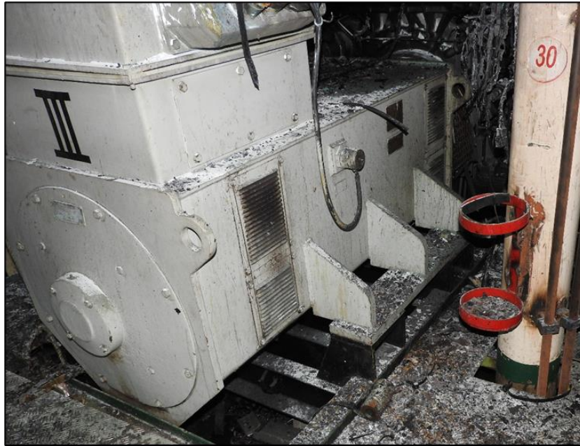
Figura 3. Alternador del motor auxiliar N.º 3
