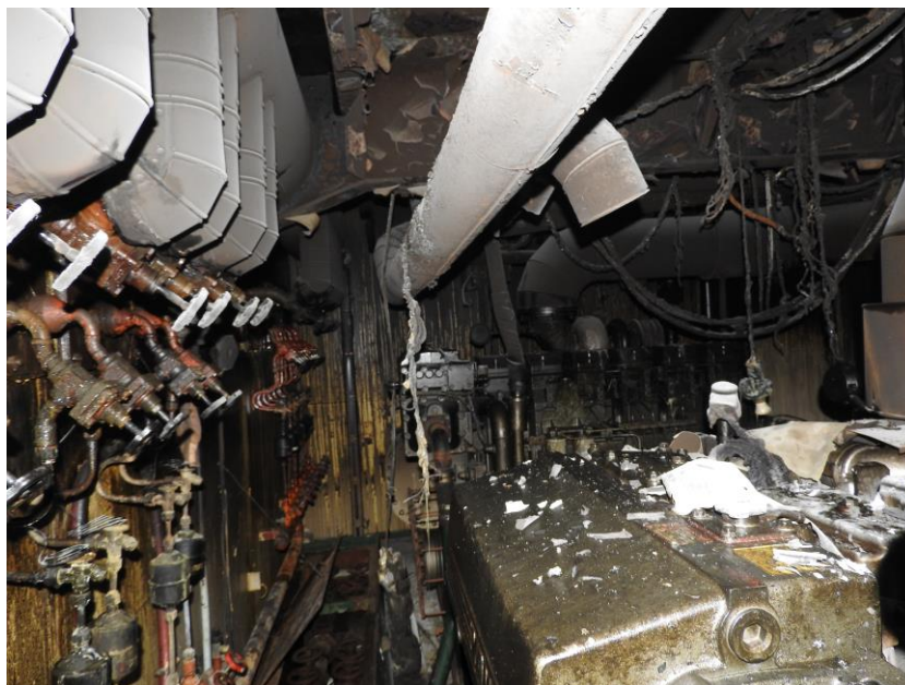
Figura 8. Sector a proa de los motores auxiliares N.º 2 y 3 Fuente Material documental.
