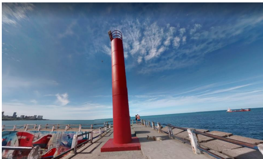
Figura 2. Escollera norte. Baliza color rojo. Altura 9,7 m. Luz roja con destellos cada 3 segundos
