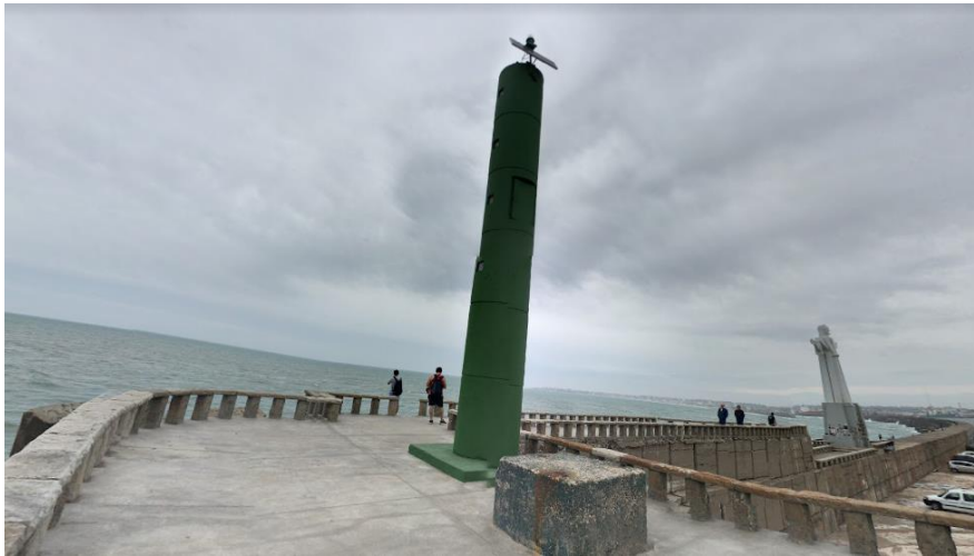
Figura 3. Escollera sur. Baliza color verde. Altura 9,7 m. Luz verde con destellos cada 3 segundos
