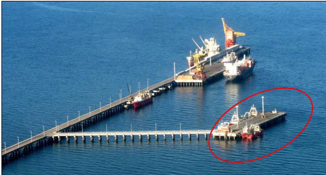
Figura 6. Se destaca el muelle pesquero en el muelle Almirante Storni. Se observa el viaducto secundario que conecta el muelle pesquero con el viaducto principal
