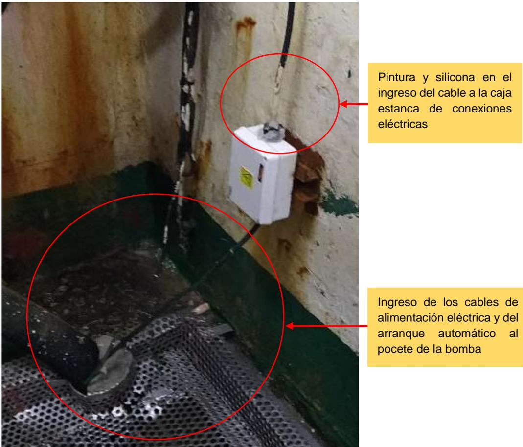
Figura 18. Se observa la instalación de la bomba luego de los trabajos realizados con posterioridad al suceso
