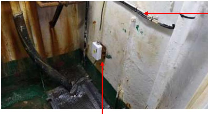
Cable de alimentación eléctrica y del arranque automático de la bomba, precintados a un anclaje en el mamparo
