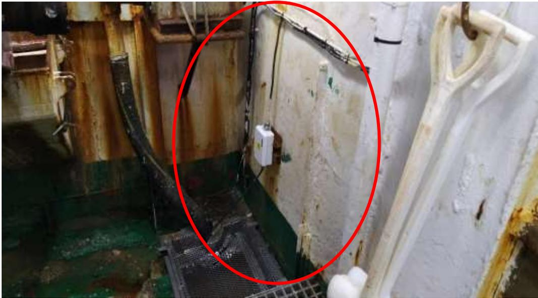
Figura 16. Dentro del círculo rojos se ve las modificaciones realizadas en la instalación eléctrica del cable de alimentación de la bomba sumergible de estribor. Se observa que luego del suceso se instaló una caja de empalmes en el lugar donde el cable estaba empalmado, aproximadamente ubicada medio metro sobre el pocete
