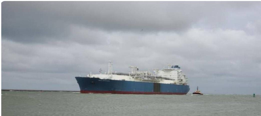
Figura 1. Vista del B/T Hoegh Esperanza por su banda de babor.
