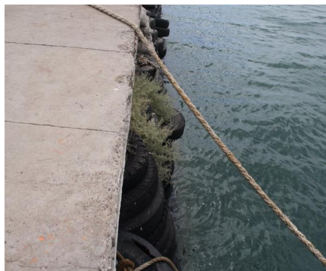
Figura 9. Frente de atraque. Cubiertas de automotor como defensas.
