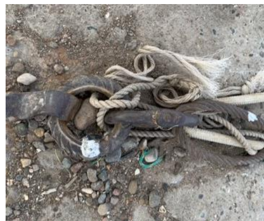
Figura 8. Puntos de amarre con anillas de acero.
