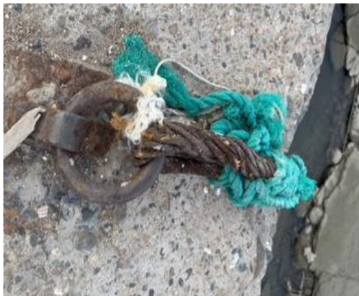
Figura 8. Puntos de amarre con anillas de acero.
