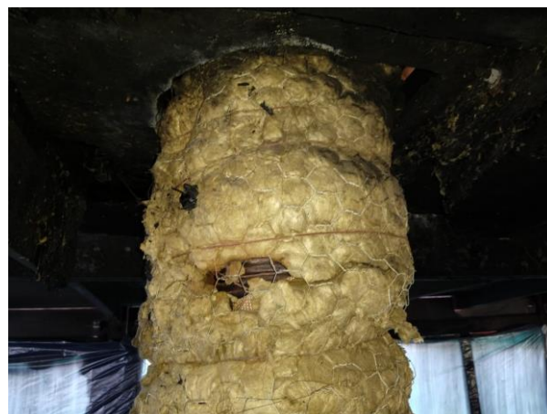
Figura 8. Intersección cielo y sistema de exhaustación.
