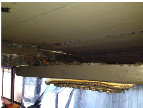
Figura 10. Daños en cableado principal de iluminación, sector medio de la lancha.
