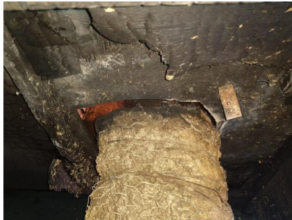
Figura 7. Intersección cielo y sistema de exhaustación.
